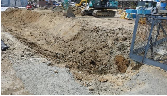
(写真1-1) 上流水槽設置予定地の状況 (北東側から撮影)
