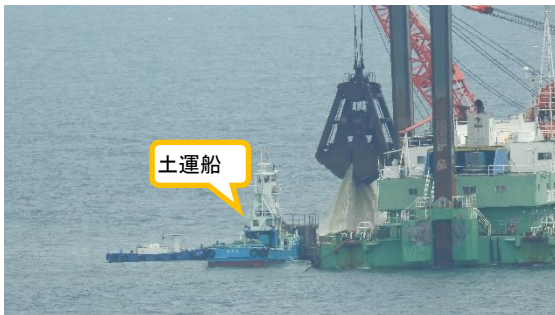
(写真3-2) 掘削した土砂の運搬作業の状況
