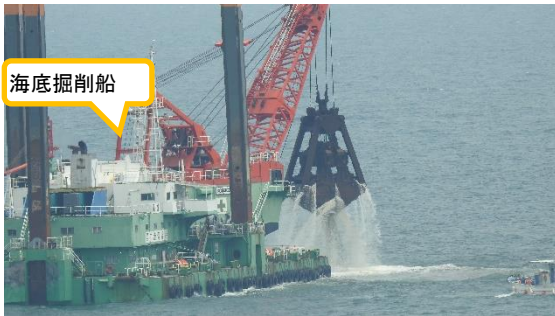
(写真3-1) 海底面を掘削する海底掘削船の状況
