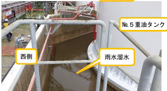
(写真4-2) No. 5 軽油タンクの防油堤内の状況② (南側から撮影)
