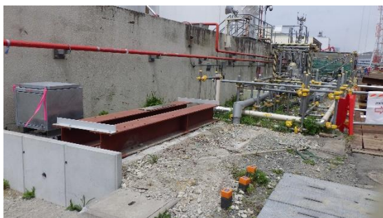
(写真5-2) 軽油タンク防油堤東側外壁付近の配管敷設状況 (南東側から撮影)
