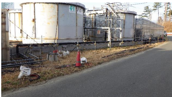
(写真1-1) Fタンクエリア外観 (北東側から撮影)
