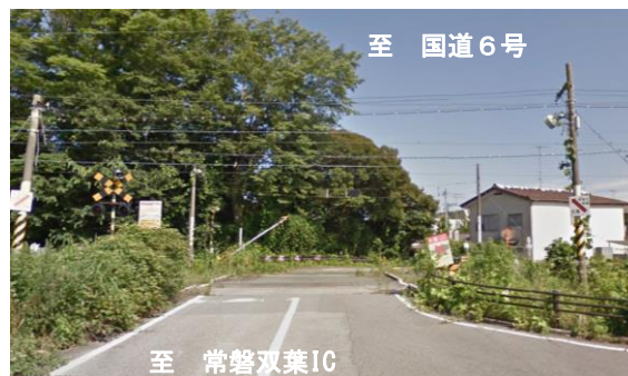
【写真② JR跨線橋区間の状況】
