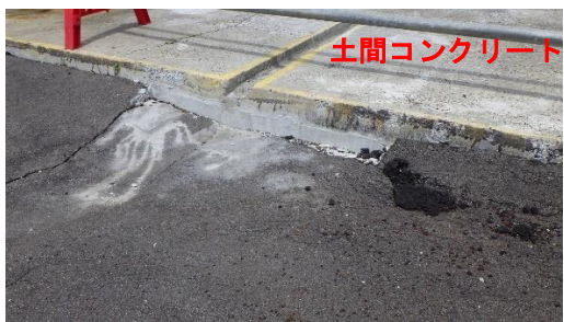
(写真3-3) 陥没対応の状況
