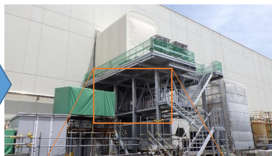
(写真1-2) プロセス主建屋南側壁面の状況 (令和4年6月16日撮影)
