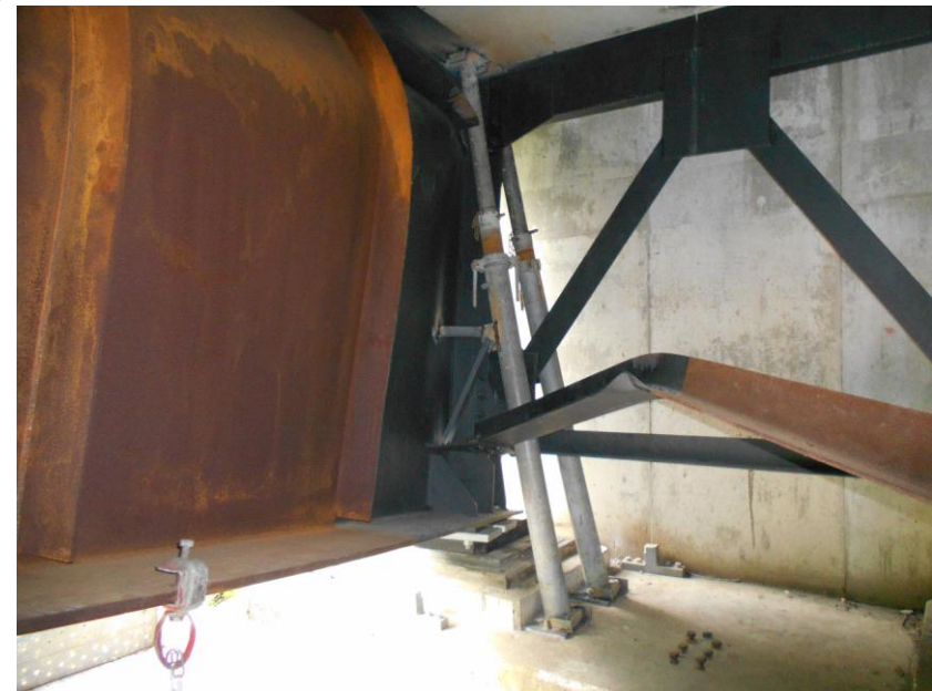
※橋台（只見側）のG1桁・谷側
