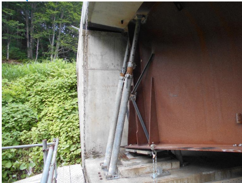
※橋台（只見側）のG1桁・山側
