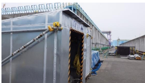
(写真 3-3) 第三施設における資機材仮置き状況 (南東側から撮影)
