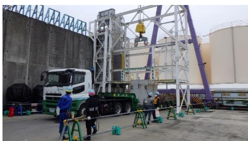
(写真 4-2) 第三施設においてトレーラーからHICを取り出す状況
