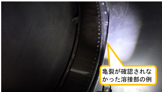
(写真3) ロータリーキルン（B系）の状況 ※ロータリーキルン下部方向から撮 影
