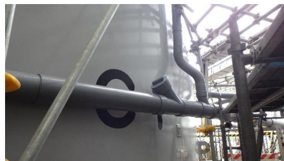
(写真 3 - 2) 修繕された雨樋配管の例 (令和 4 年 7 月 12 日)
