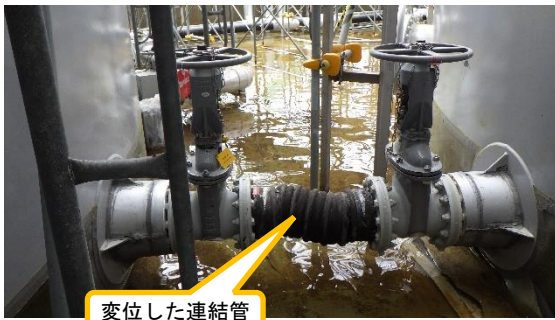
(写真1-1) 連結管取り外し前の状況 (令和4年3月29日撮影)
