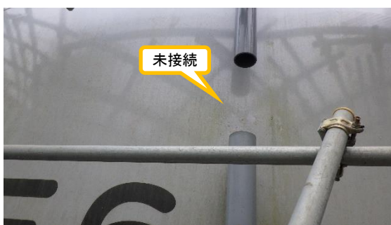
(写真 3 - 1) 破損した雨樋配管の例 (令和 4 年 3 月 29 日 撮影)
