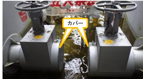
(写真1-2) 連結管取り外し後の状況 (令和4年7月12日撮影)
