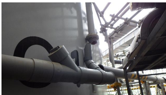
(写真 3 - 1) 破損した雨樋配管の例 (令和 4 年 3 月 29 日 撮影)
