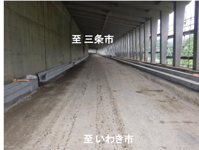
スノーシート工事状況
