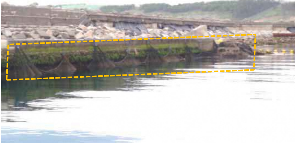
2013年6月設置直後（南防波堤）の状況
