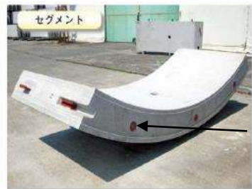
スクリューボルト継手 (接続部)
