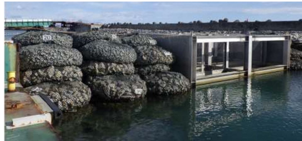
図③ 完成写真（2021年10月20日撮影）
