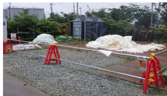
(写真2-2) 管理者不明コンテナの撤去跡の状況 (令和4年6月24日撮影)
