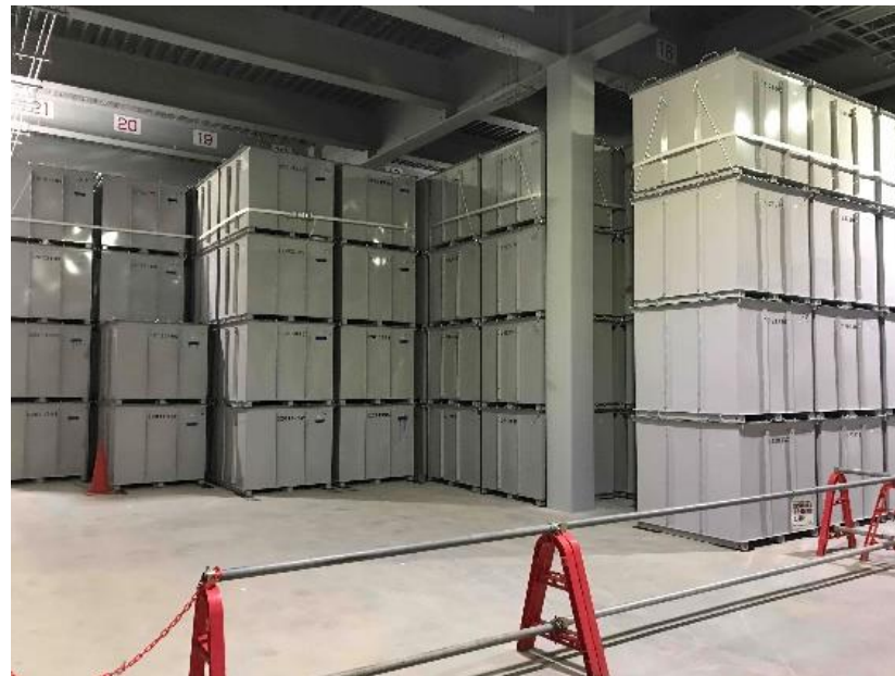
廃棄物貯蔵施設内の貯蔵状況
