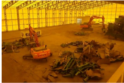
受入・分別施設(解体中)
