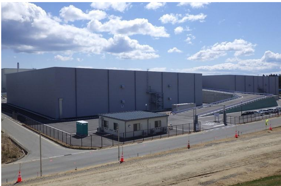
廃棄物貯蔵施設の外観
