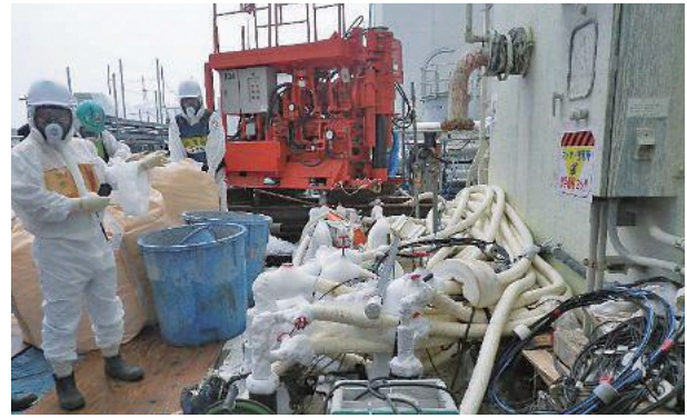
2号機海水配管トレンチ止水工事状況
