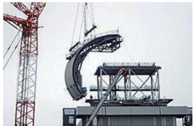
3号機燃料取り出し用カバー設置
