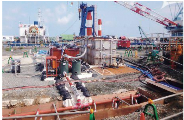
ウェルポイントによる汚染地下水汲み上げ
