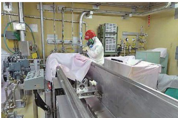
汚染の除去作業状況（東京電力提供）
