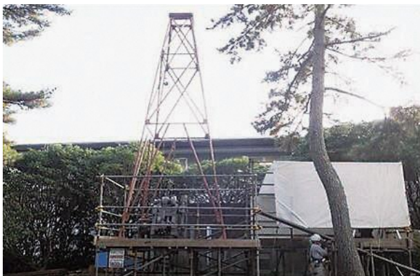
ボーリング調査の状況（東京電力提供）
