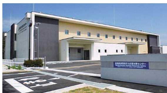
福島県楡葉原子力災害対策センター (双葉郡楡葉町大字山田岡字仲丸1-77)
