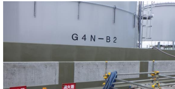
(写真1-3) G4北タンクエリアの堰の状況 (今回(7月22日)撮影)
