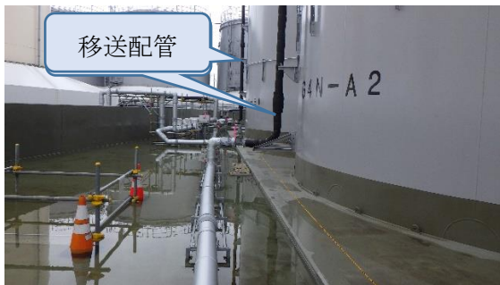
(写真1-2) G4北タンクエリアの堰の状況 (前回(6月7日)撮影)
