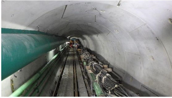
(写真7) 放水トンネルの状況
