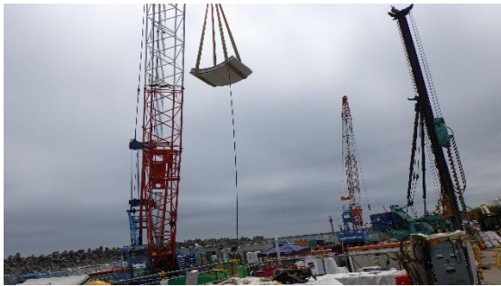
(写真5-1) 資材の放水立坑（下流水槽）内への 運搬状況①
