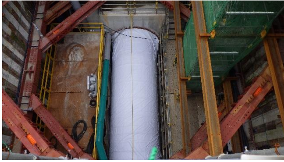
(写真4) 放水立坑（下流水槽）内の状況 ※白い円筒状の仮資材の写真上側が 放水トンネル
