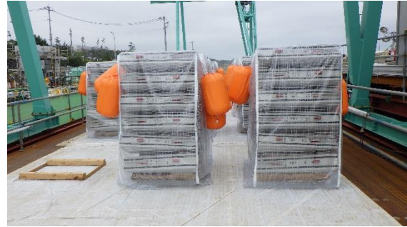
(写真1-2) 橋形クレーン下部に保管されていた 資材 (令和4年8月22日撮影)
