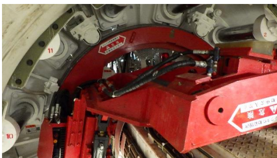
(写真6) 資材を組み込む機器（赤い部分） ※機器の先方にシールドマシンの掘 削部がある。
