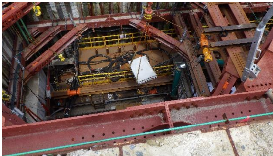
(写真5-2) 資材の放水立坑（下流水槽）内への 運搬状況②
