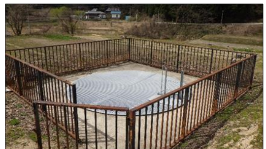
地すべり防止施設の更新状況
