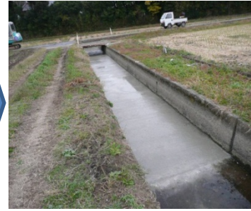
補修した水路
