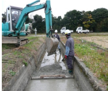
自主施工による補修作業
