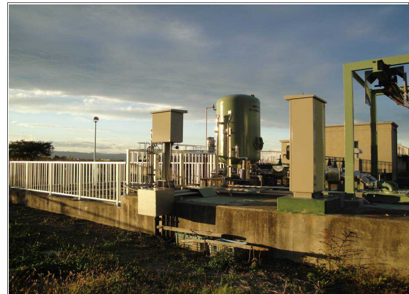
写真2-2 水処理施設復旧状況
