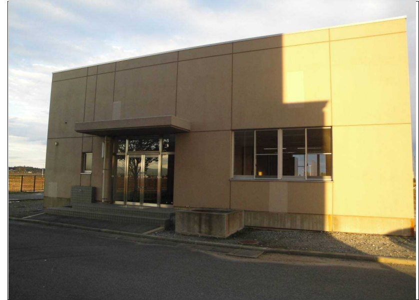
写真1-2 管理棟復旧状況
