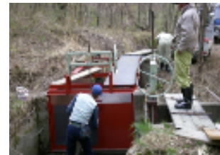
地域の鉄鋼屋さんの力を借りて自作低コストゲートの設置
