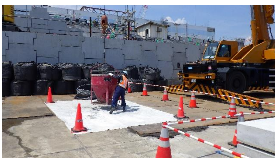
(写真4-2) コンクリート打設作業の状況 (南東側から撮影)
