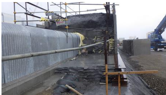
(写真3-1) 金属製のU字状の枠の設置状況 (令和4年5月27日南東側から撮影)
