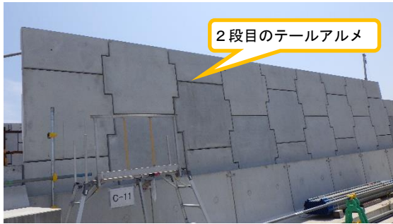
(写真2) テールアルメの設置が二段目まで進んでいる箇所の状況 (北西側から撮影)
