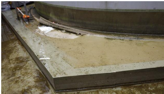
(写真5) 堰床面被覆膜の状況
