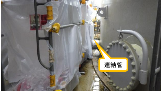
(写真7) 連結管及び周囲のビニールハウスによる養生の状況
