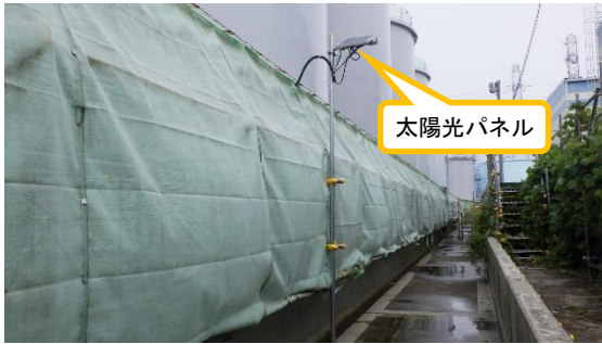
(写真2) 新地震計の太陽光パネルの設置状況 (エリア東側を南側から撮影)
