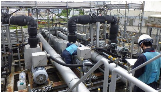
(写真3) ポンプ起動の確認状況
