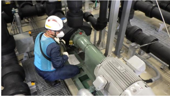
(写真7) ポンプ起動の確認状況
