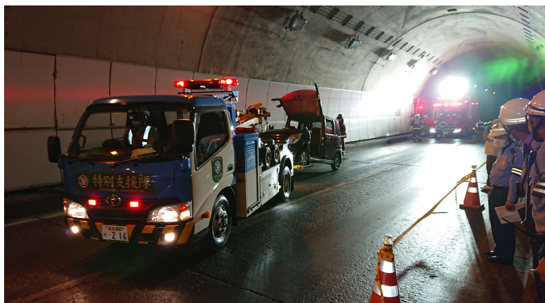
二次災害を防ぐため大破した車両を一早くトンネルの外へ
