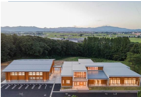
林業研修拠点施設
