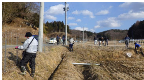
地域住民主体でイノシシ侵入防止柵を設置している様子
