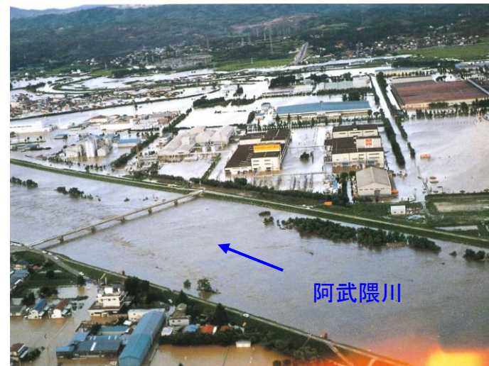
昭和61年8月洪水 郡山中央工業団地の浸水状況
