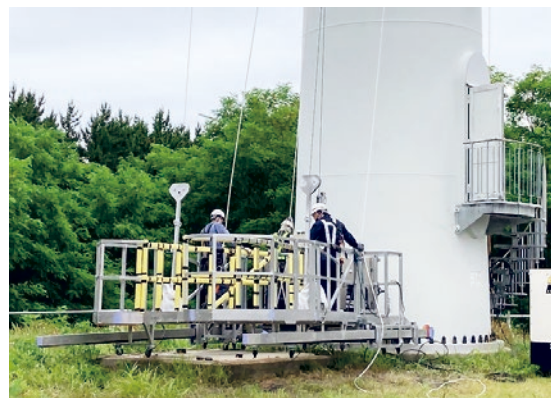
メンテナンス用ゴンドラ設置風景
