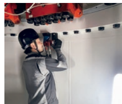
ボルト締結作業
