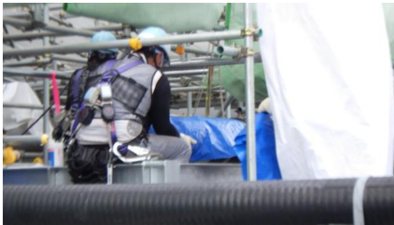
(写真6) PE管の溶着作業の状況 (エリア東側 を南東側から撮影)
