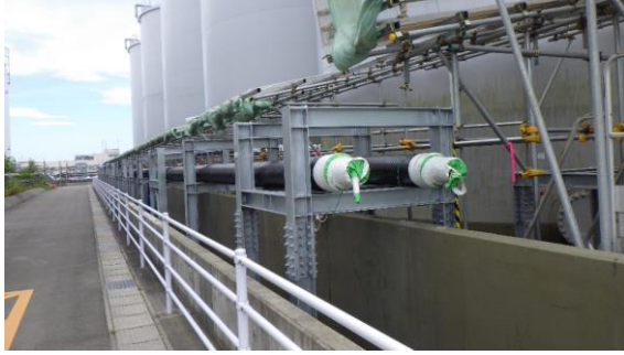
(写真5) 配管として使われるPE管の設置状況 (エリア北側を北西側から撮影)
