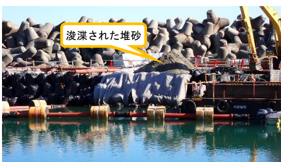
(写真2) 5・6号機取水路開渠付近の状況
