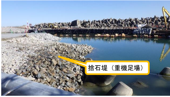
(写真3) 重機の足場として用いる捨石堤
