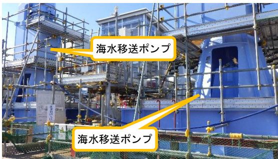
(写真1-2) 設置中の海水移送ポンプ
