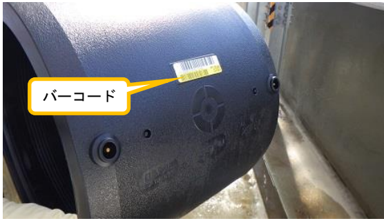
(写真 2-2) 配管を挿入するソケット
