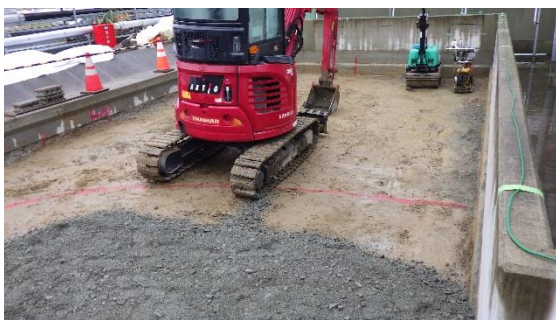
(写真 3-1) K4 タンクエリアの北東部における 基礎工事の状況 (10月 5 日撮影)
