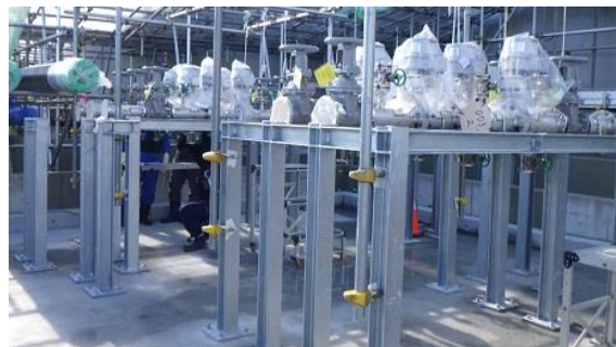
(写真 3-2) K4 タンクエリアの北東部における 配管・弁の設置工事の状況 (11月 25 日撮影)
