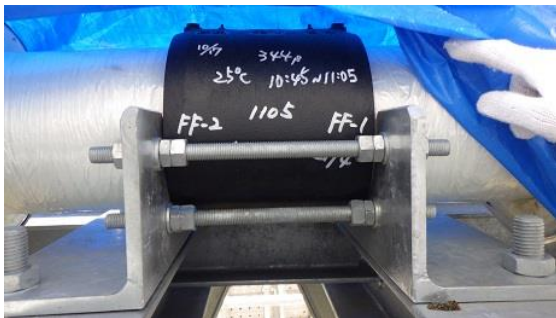
(写真 2-3) 融着後の配管
