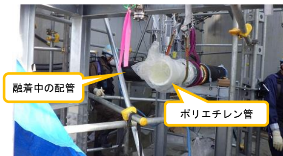
(写真2-1) 配管の融着作業の状況
