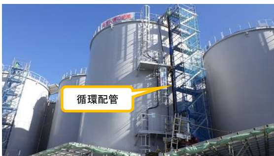
(写真 4) タンクとタンクを接続する循環配管 の設置状況
