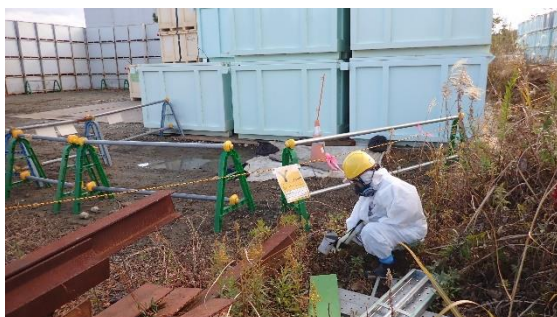
(写真4) 一時保管エリアF1周辺の地表面の線量率測定状況の例 (高い線量率が確認されたエリアの北西側の地表面の測定状況) (北西側から撮影)
