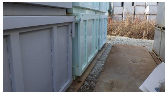
(写真3-2) 高い線量率が確認されたエリアの区画があった箇所の現在の状況（北東側から撮影）
