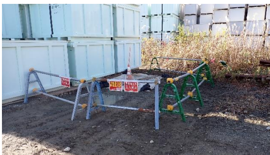
(写真3-1) 高い線量率が確認されたエリアの区画状況（北東側から令和4年12月12日撮影）
