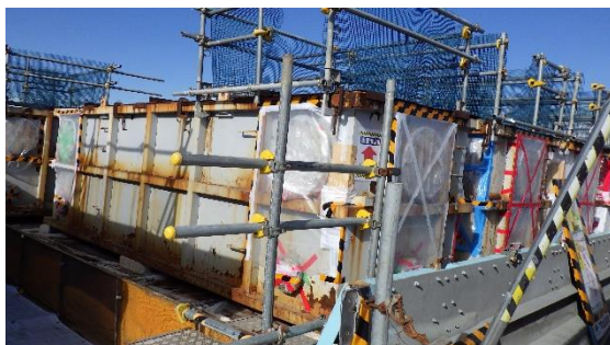
(写真2-1) 受水タンク保管状況
