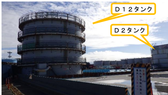
(写真1-2) Eタンクエリアの状況②
