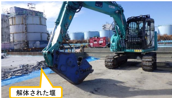
(写真3) 解体された堰及び重機の状況
