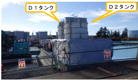
(写真1-1) Eタンクエリアの状況①
