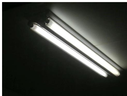
図3 蛍光灯カバーによる飛散防止
