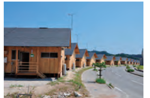
木造応急仮設住宅(いわき市)
