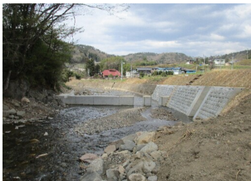
五斗蒔新堰(頭首工)復旧後
