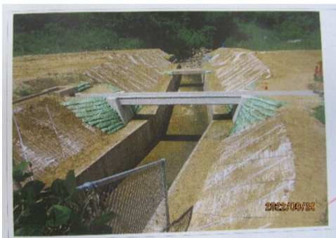
足駄木(ため池排水路)復旧後
