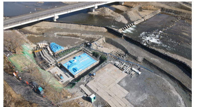
伊香堰施工中 (R5.1月上旬撮影)
