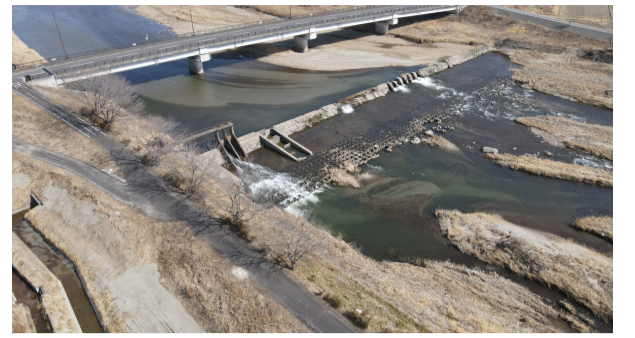
伊香堰施工前 (R4.3月上旬撮影)
