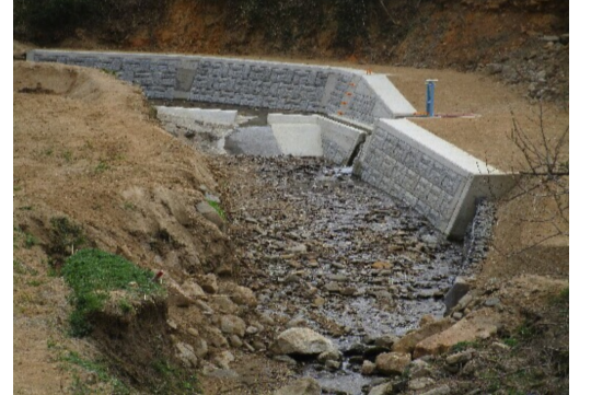
梅ノ木沢堰第1(頭首工)復旧後
