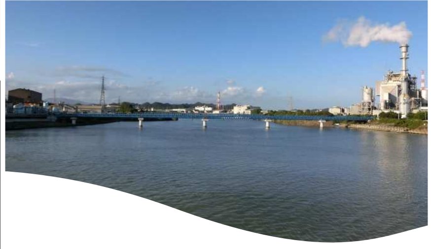
藤原川 みなと大橋上流
