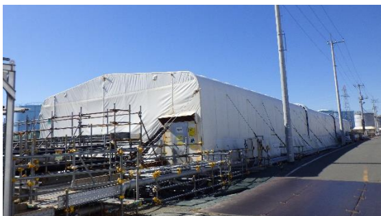
(写真1-1) RO-3建屋 (ジャバラハウス) の 外観 (北東側から撮影)
