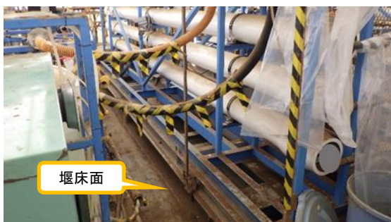
(写真 4) RO-3 堰内の状況 (逆浸透膜スキ ッド 2 周辺)
