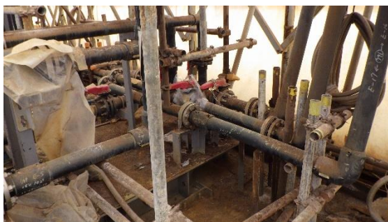
(写真5-1) 出口弁の状況①
