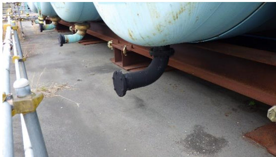
(写真 3) タンク下部のフランジの養生状況の 例 (ブルータンクエリアC)
