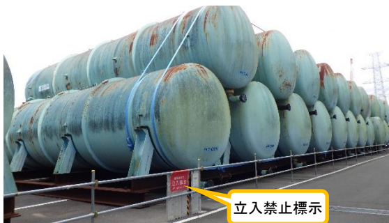
(写真1-1) ブルータンクエリアAの外観 (南西側から撮影)
