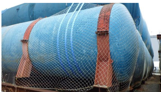
(写真2-2) タンクと台座等の固定の例② (ブルータンクエリアD)
