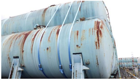
(写真 2 - 3) 上段タンクと下段タンクの固縛の例 (ブルータンクエリアC)
