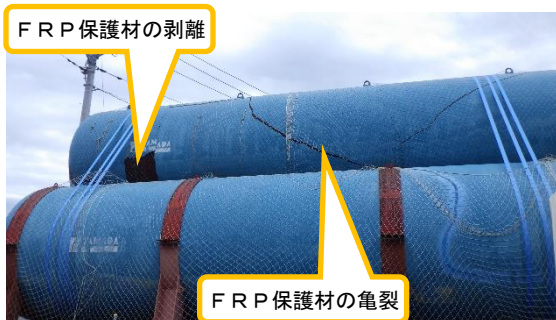
(写真 4) FRP 保護材の飛散防止対策の状況 (ブルータンクエリアD)
