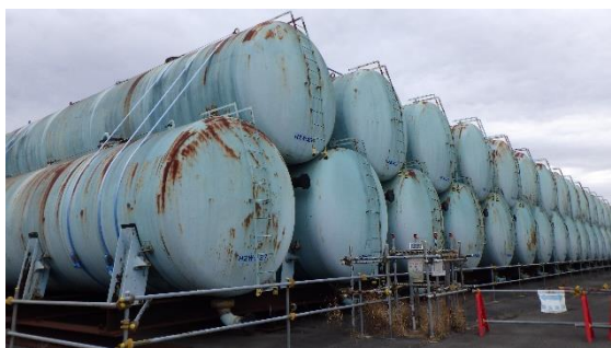
(写真1-2) ブルータンクエリアCの外観 (南東側から撮影)
