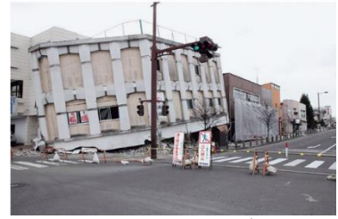
▲地震で倒壊した建物（須賀川市）
