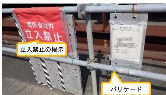
(写真1-2) ブルータンクエリアCのバリケード の状況
