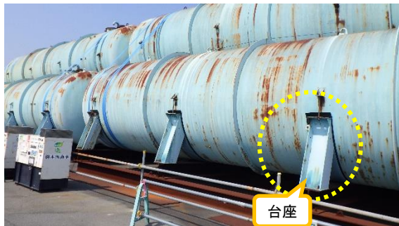
(写真2-3) ブルータンクエリアBの台座固定の例
