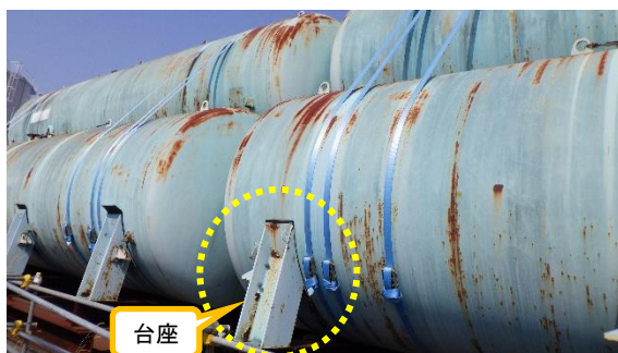
(写真2-4) ブルータンクエリアCの台座固定の例
