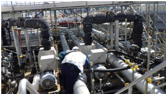
(写真 3) 排水ポンプ起動の確認状況
