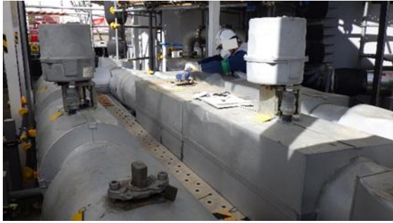
(写真 2 - 2) 排水するグループ 3 排水弁の「全開」作業の状況
