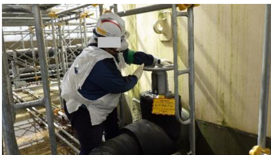
(写真5-2) 排水する一時貯水タンク（G）の出 口弁「開」操作状況
