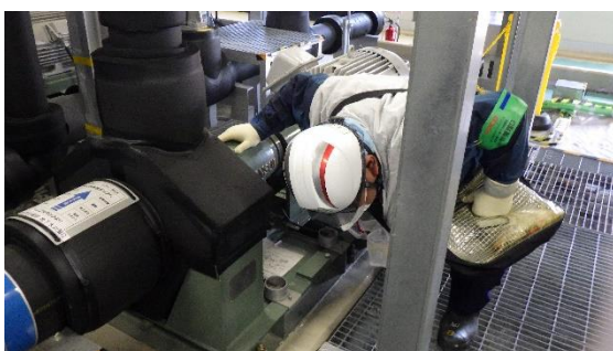
(写真6) 移送ポンプ起動の確認状況
