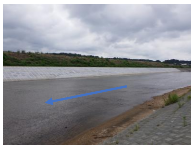
谷田川 河川改修
