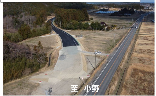
小野富岡線 高津戸工区（富岡町）
