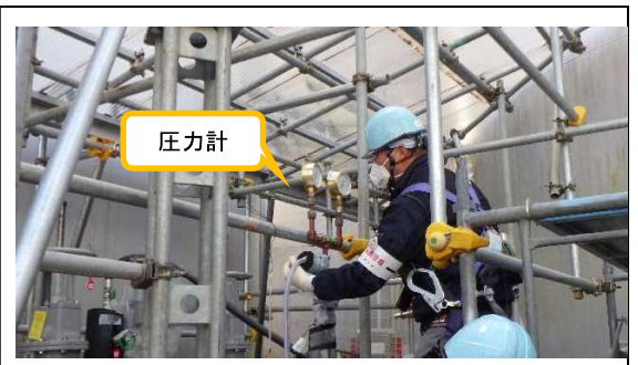
(写真 1-2) 耐圧試験の状況
