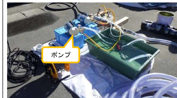
(写真 1-3) 配管内の水張りに使用するポンプ等
