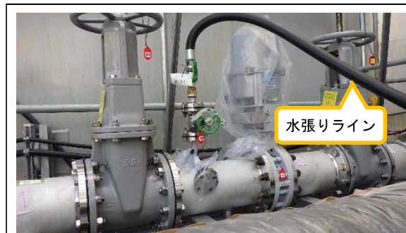
(写真 1-1) 耐圧試験の状況
