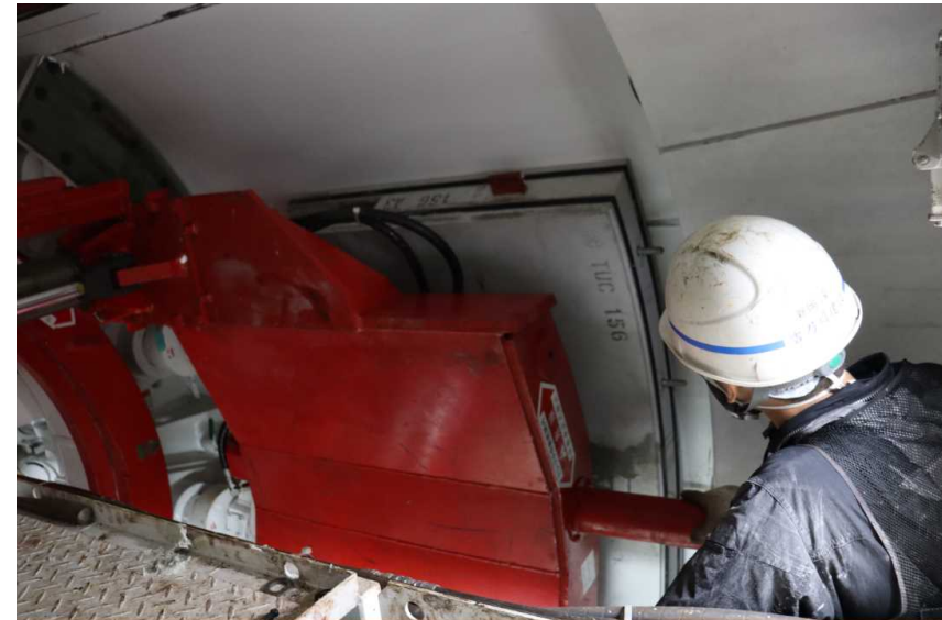
セグメント組立状況
