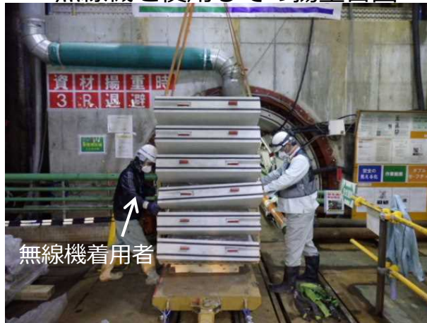
無線機を使用している揚重合図
