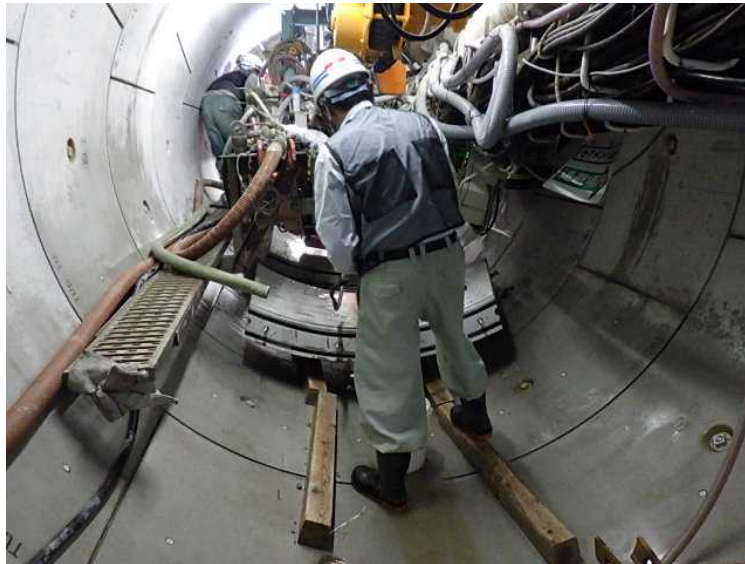
インバート部への仮置き状況
