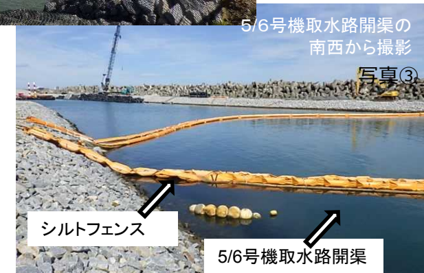
5・6号機海側工事エリアの状況
