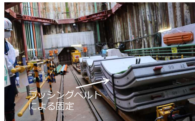
セグメント搬送時の固定
