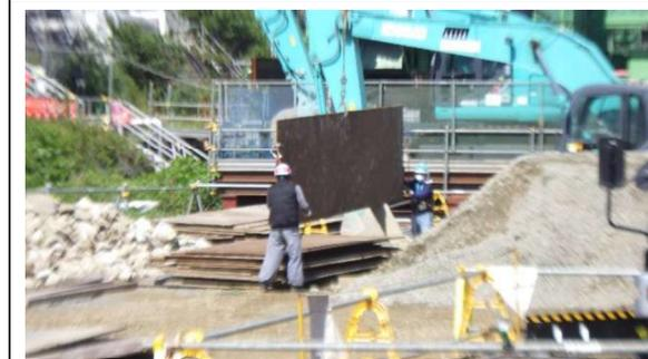
(写真2) 均し作業準備のため鉄板を移送している状況
