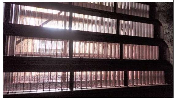
(写真1-2) 取水路のスクリーンの様子
